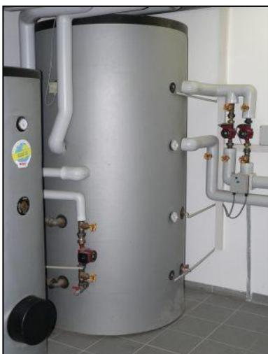
Warmwasserspeicher einer Solaranlage
